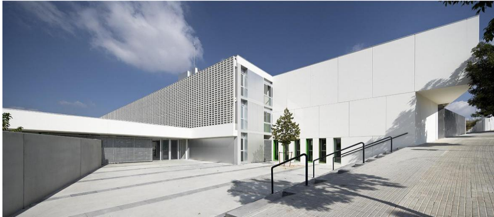
(Foto 1: Fachada del instituto[1])
